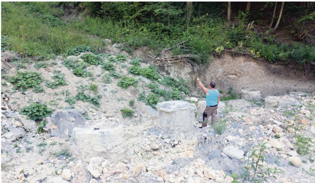
Za zavarovanje vasi Stopce, ki jo ogroža velik plaz, bo treba izvesti dodatne ukrepe. Predvideni sta gradnja dodatne betonske strukture ter postavitve zagatne stene na izvoru plazu. V Občini Laško računajo, da bi se dela lahko začela letošnjo jesen. (Foto: Andraž Purg)
